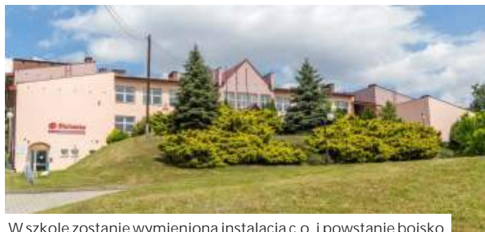
W szkole zostanie wymieniona instalacja c.o. i powstanie boisko
