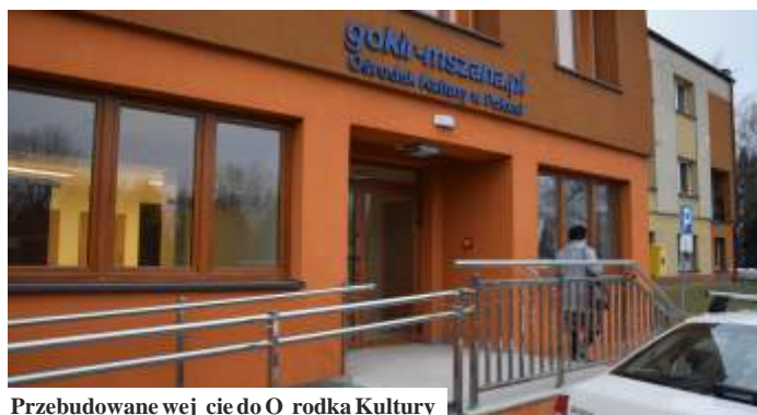
Przebudowane wejście do Orodka Kultury
